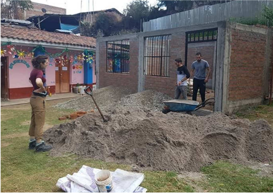
Annexe 16 : Construction de la salle de classe à Rumi-Rumi
