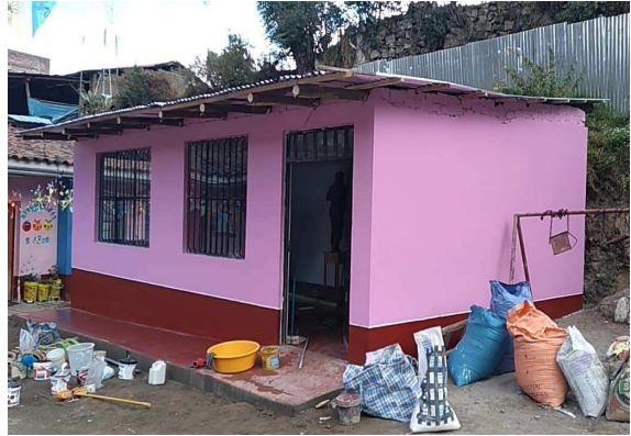
Annexe 17 : Salle de classe terminée
