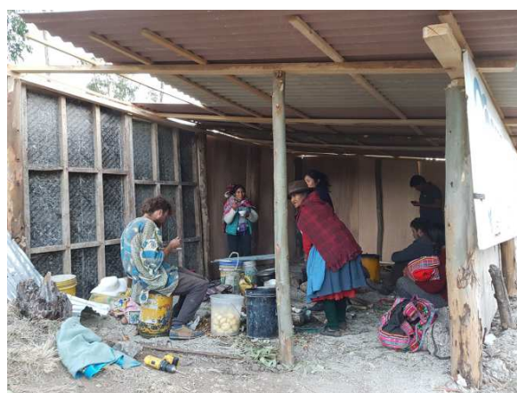
Annexe 6 : Intérieur de la maison en construction
