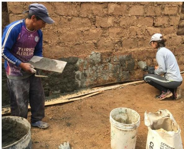
l'extrémité des pierres servant de fondation afin de bétonner au mieux le bas des murs. Nous nous sommes fait la réflexion, par ailleurs, qu'un composteur pouvait être profitable à l'enrichissement de la terre ; nous en avons entrepris la construction, à grand renfort de tronçonneuse.
