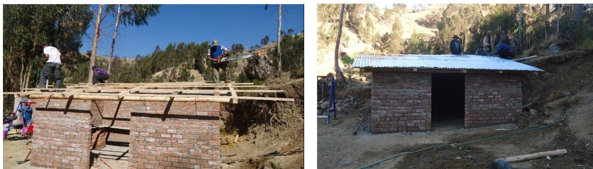
*Mise en place de la charpente et des tôles*
