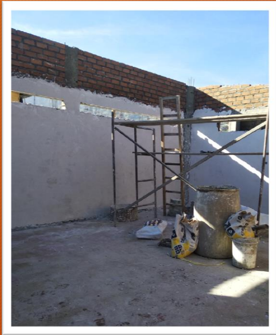
Le chantier, lors de mon arrivée à MUNAY WASI
